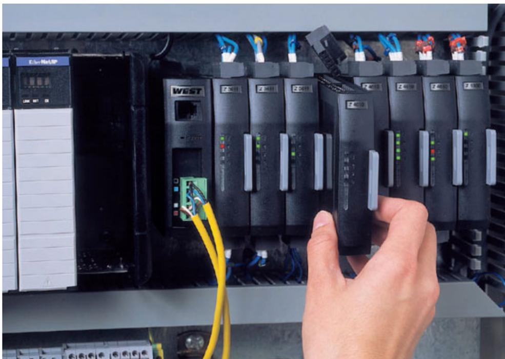
MLC 9000 – это модульный многоканальный регулятор температуры, поддерживающий широкий спектр промышленных сетей. Он может легко и без какого-либо программирования обмениваться данными с ПЛК. В MLC 9000 реализована технология регулирования температуры, ориентированная на простоту использования, которая позволяет управлять сложными температурными профилями. К одному модулю-регулятору можно подключить до 16 модулей входов-выходов.
